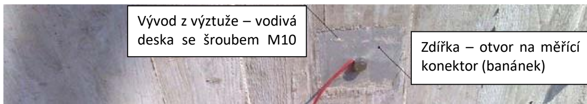
Obrázek č. 6: Schema elektricky vodivého pospojování výztuže pilot a patek (pro stupeň 4 povinné):
